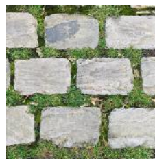
Pavés à joints végétalisés
