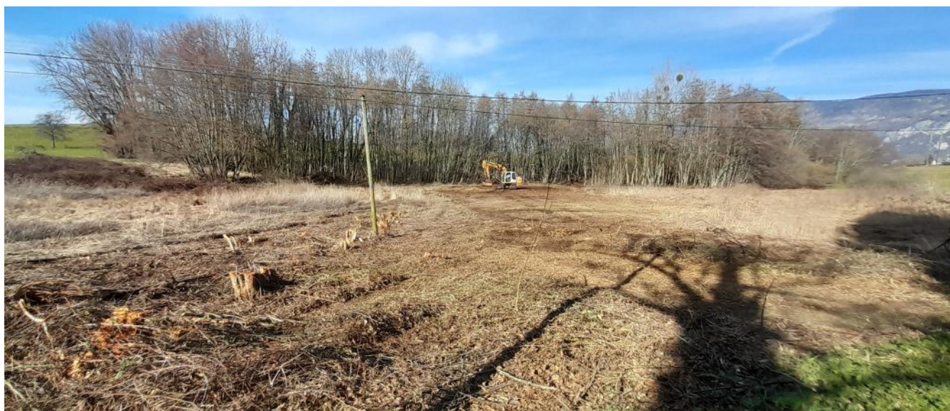
Les travaux de destruction des espèces ligneuses au Bonivard
